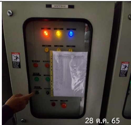
รูปที่ 2-11 ระบบควบคุมไฟฟ้าสำหรับระบบบำบัดน้ำเสีย
